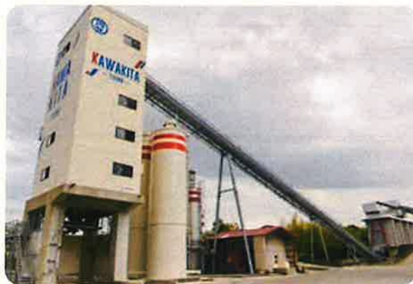
ミキサーの更新に合わせて建設された新たなプラント。
