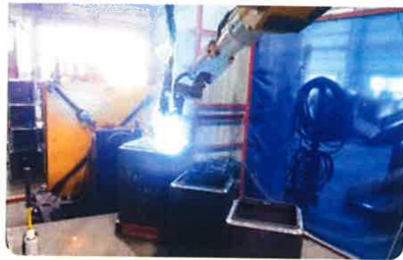
セッティングしておけば夜間や昼休憩時など 無人の間も溶接作業を行えるようになった。
