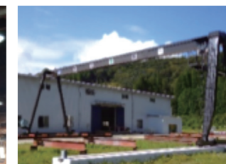
橋形クレーン
