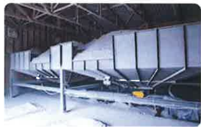
新工場に新設された選別・小分けライン。多くが手作業で行われたものが自動化されました。
