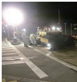
【図1】夜間工事現場
